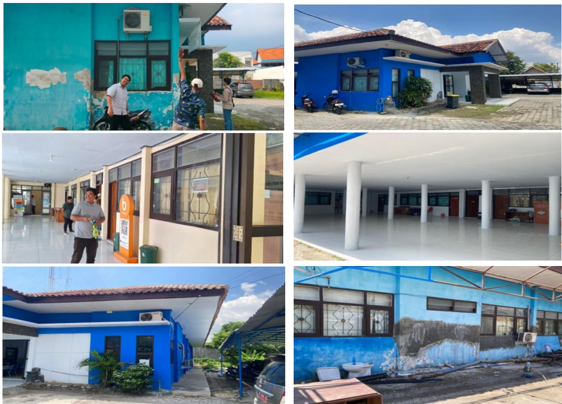
Rehab gedung kantor Diskominfo
